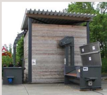
Figura 3.5 – Silo fuori terra (42-82 m 3 ) con sistemi di carico a coclea e/o pneumatico.
