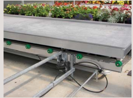
Figura 1.6 - Banchi mobili in alluminio riscaldati da un efficiente sistema radiante a bassa temperatura
